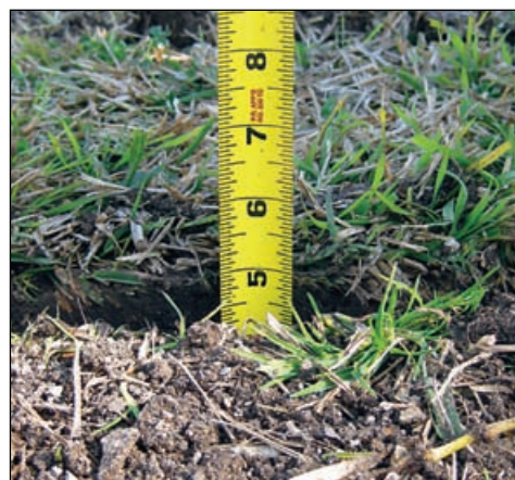
Убедитесь, что глубина капельной линии постоянна по всей установке
